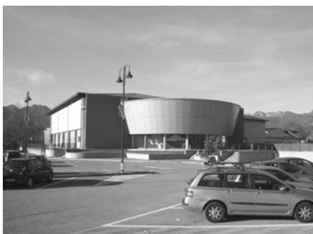
Palazzetto dello Sport all'esterno
