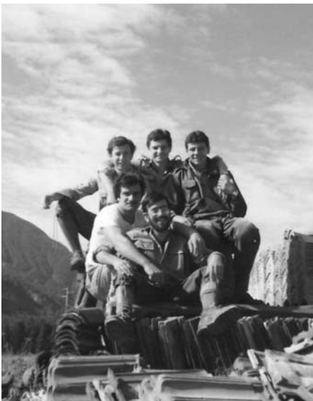
Raffaele (in alto a destra) ed Antonio (in basso a sinistra) nel cantiere n.5 di Via Piave sopra un cumulo di tegole
